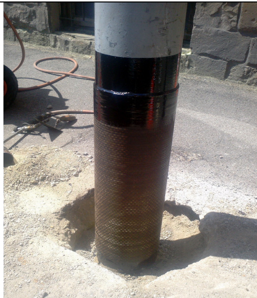
2- Applicazione guaina bituminosa e sigillatura finale
