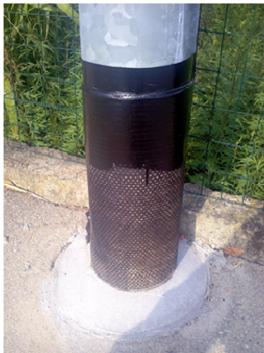
3-Collare di chiusura con malta cementizia e accentuata pendenza
